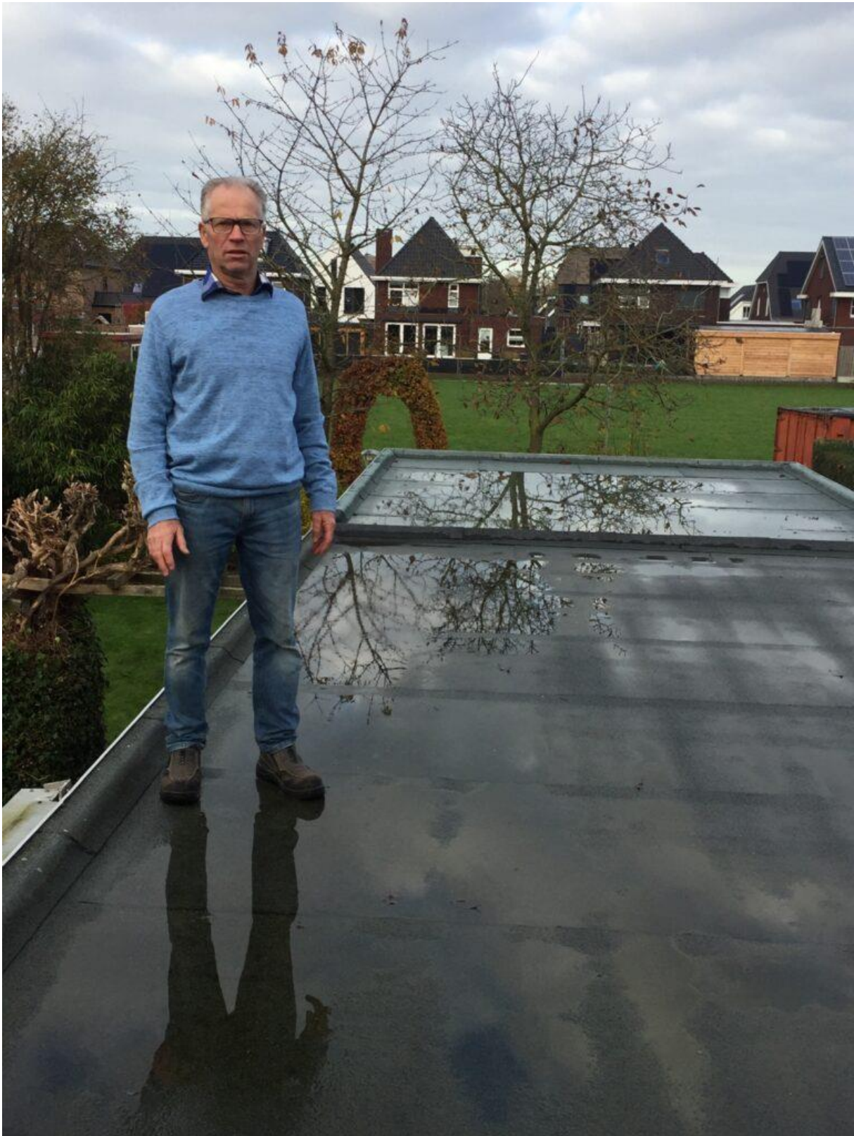
Wim van Kuijk op het dak waarop de zonnepanelen moeten komen.
