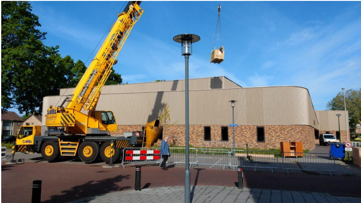
Zonnepanelen worden gelegd. (Foto Henri Hoskam)
